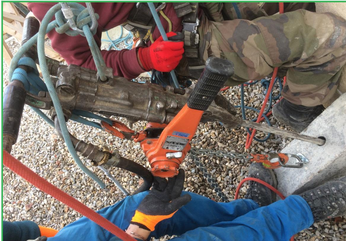
Mise en place d'une cheville à expansion mécanique au plus proche de la zone de forage (trou de foration) . Puis, y connecter un palan à chaîne directement relié à la poignée de la machine de forage . Le palan va permettre un contact indirect entre le cordiste et le perforateur manuel . Ce qui diminuera considérablement les vibrations ressenties par le technicien cordiste .
