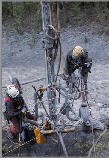
Il fréquent au début de la foration que le chariot vibre fortement à cause de son appui sur pneus
