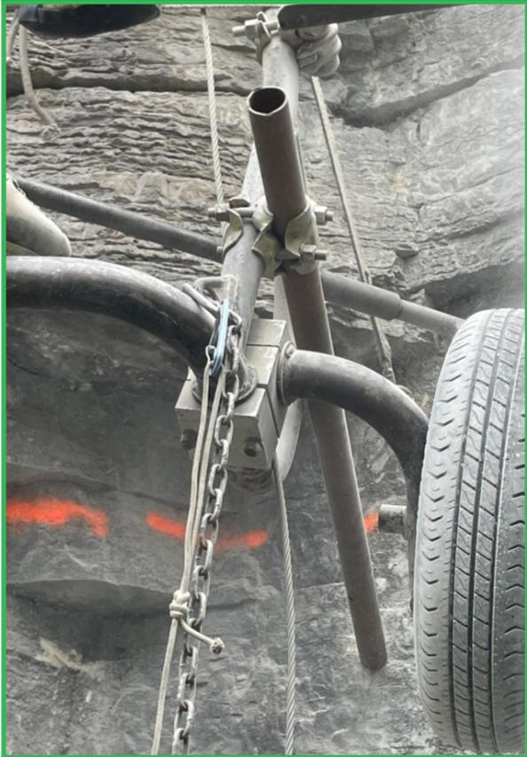
Ce dispositif permet un réglage plus rapide et plus facile du positionnement du CFL. Il est possible d'ajouter un ancrage et un pull lift pour plaquer le tube contre la paroi et ainsi diminuer encore la vibration et augmenter l'efficacité de la glissière.
