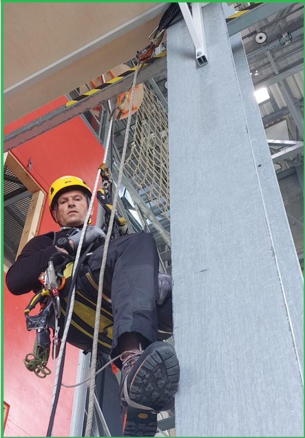
La déviation peut être effectuée de différentes façons. L'utilisation d'une longue réglable manufacturée est une des solutions la plus pratique.
